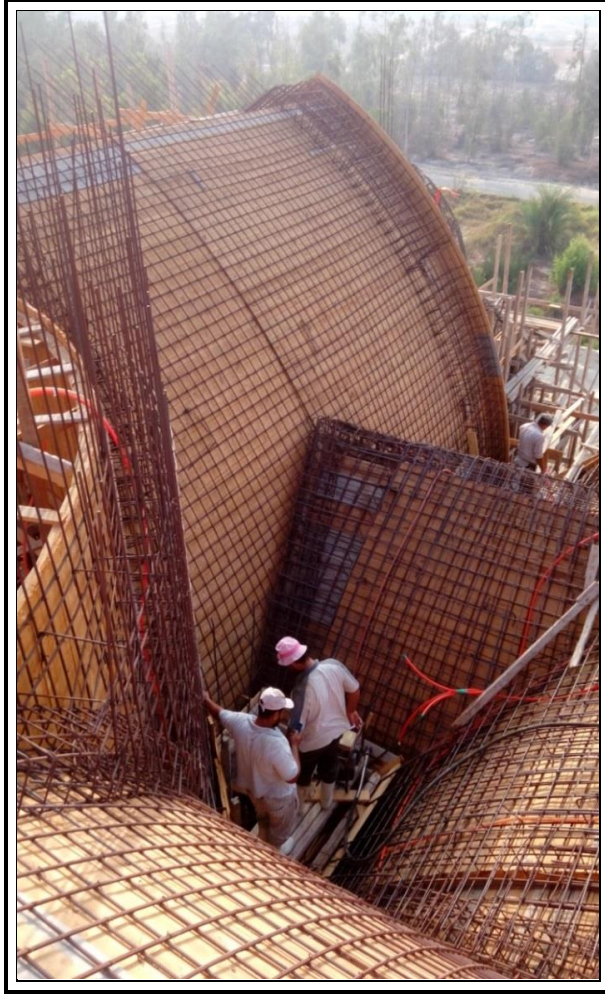
جانب من الأسقف التي تم رص حديد التسليح عليها
