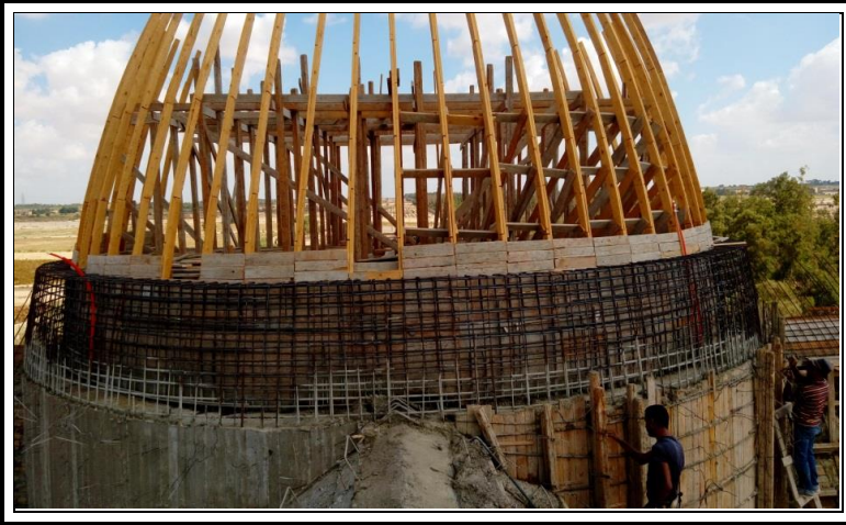
قبة الكاتدرائية أثناء أعمال النجارة
