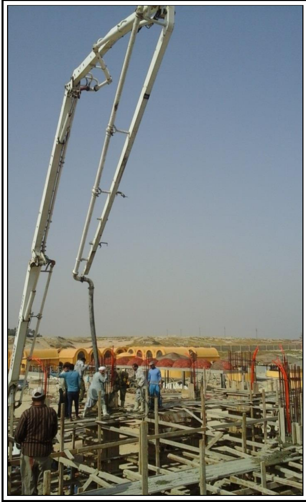
مضخة الخرسانة أثناء الصب
